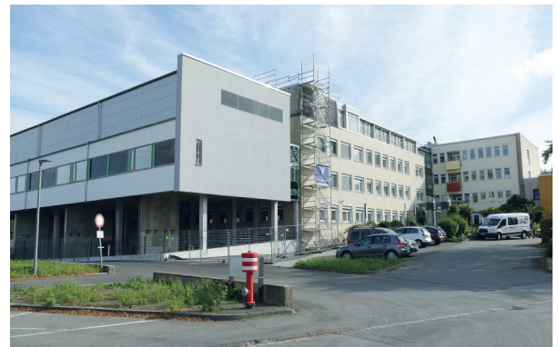
Der erste Bauabschnitt für das neue OP-Zentrum in Salzkotten ist fertig.
